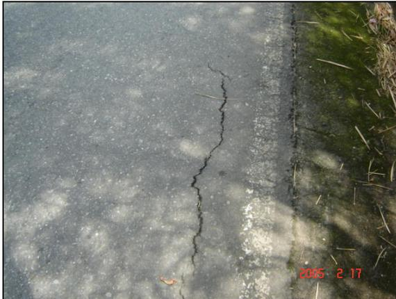
**Fotografía 6. Fisura longitudinal en junta de construcción, severidad alta**
